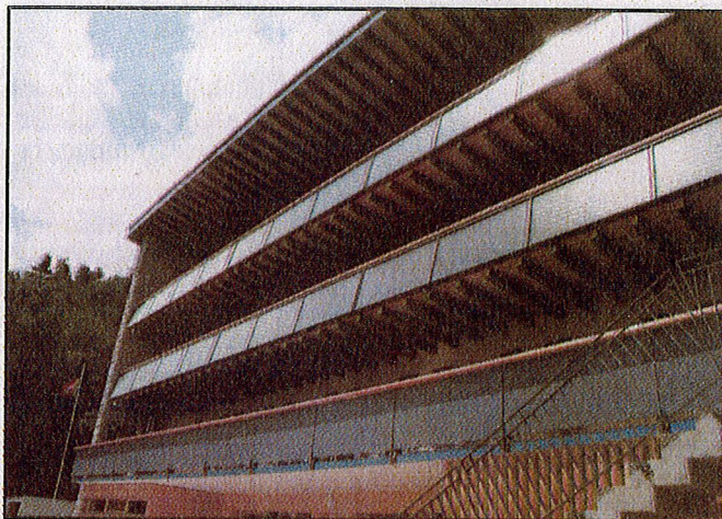
La rénovation fait la part belle au développement durable, avec, notamment, des panneaux solaires thermiques installés sur les deux immenses balcons de la façade sud. LE NOUVELLISTE
